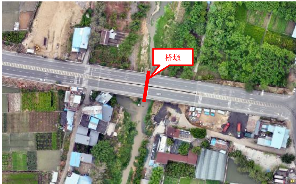
图 1-3 红鑫桥跨越情况
