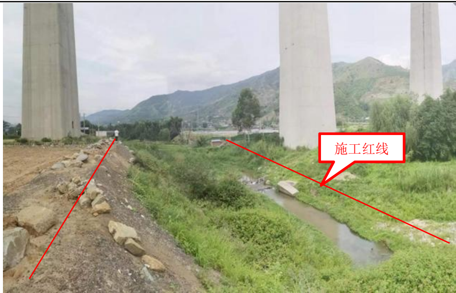
图 1-4 岷广铁路跨越情况
