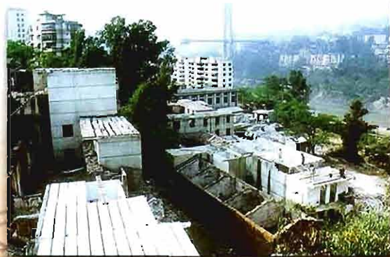
凤凰小区11万伏变电站8600平方米范围内农转非人员130余人全部拆迁
