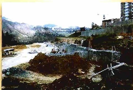
为湖光小区土地开发进行挡墙施工
