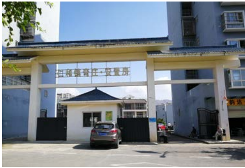
北侧：仁和镇弯庄安置房
