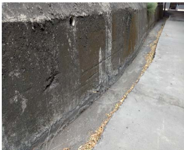
厂区雨水收集沟
