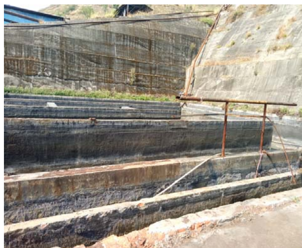
煤气洗涤水废水沉淀池
